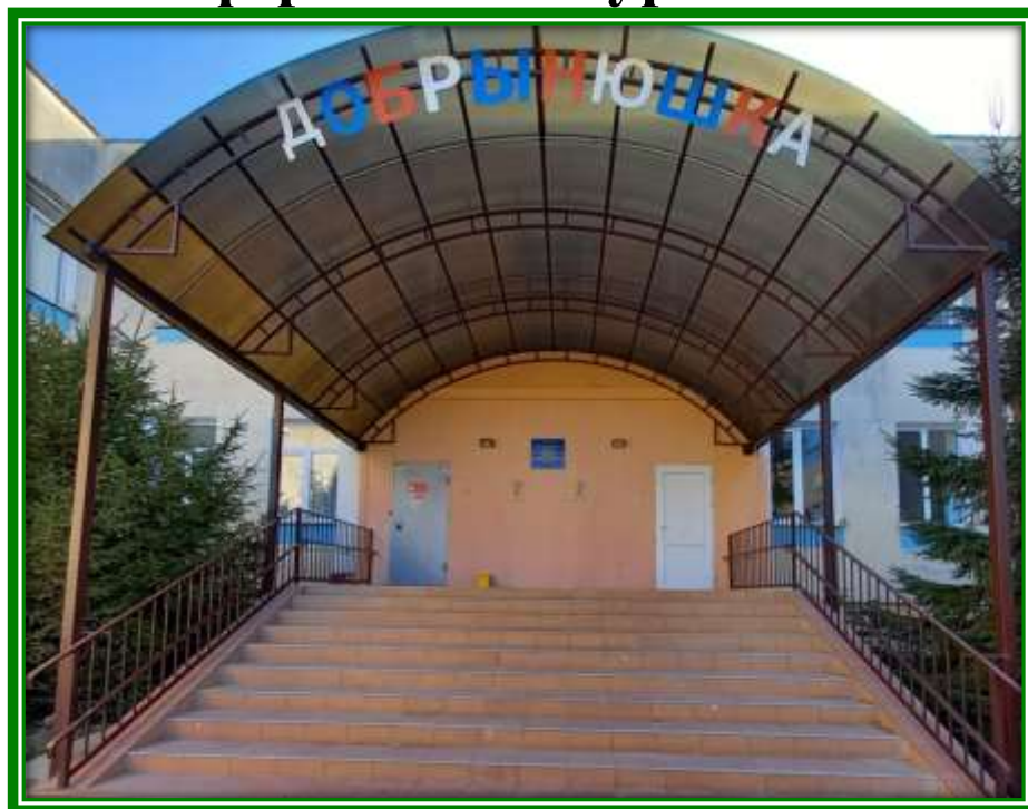
На снимке: здание МБДОУ № 97 «Добрынюшка» г. Симферополь
